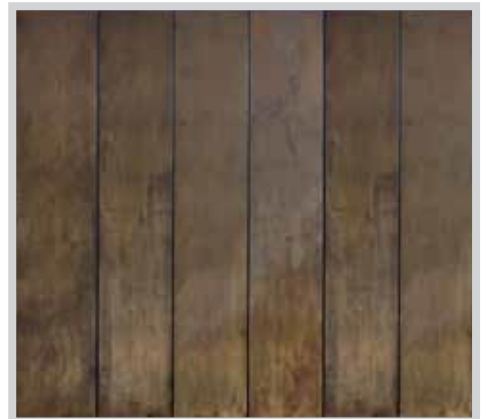
Porte latérale revêtue de panneaux en corten.
