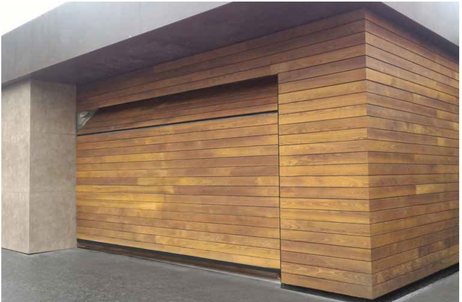
Porte de garage affleurante revêtue de planches de chêne comme une partie de la façade de la maison pour obtenir un effet de porte «dissimulé».
