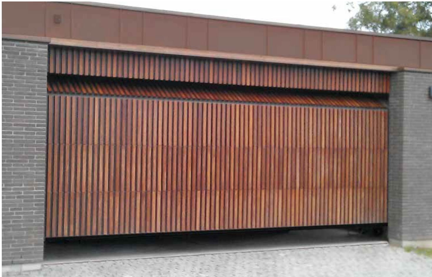
Porte de garage et faux panneau revêtus par boiseries en mélèze 50x50 mm.
